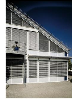
Breite Lamellen, die sich von innen in nahezu jeden beliebigen Winkel einstellen lassen, sorgen dafür, dass bei jeder Tageszeit genau die richtige Menge Licht einfällt. In einem bestimmten Winkel eingestellt, lassen die Lamellen Licht ein, verhindern aber das Aufheizen der Räume und ungewollte Einblicke.
